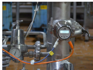
Рис. 3. Установка датчика на восходящем потоке вертикального трубопровода
